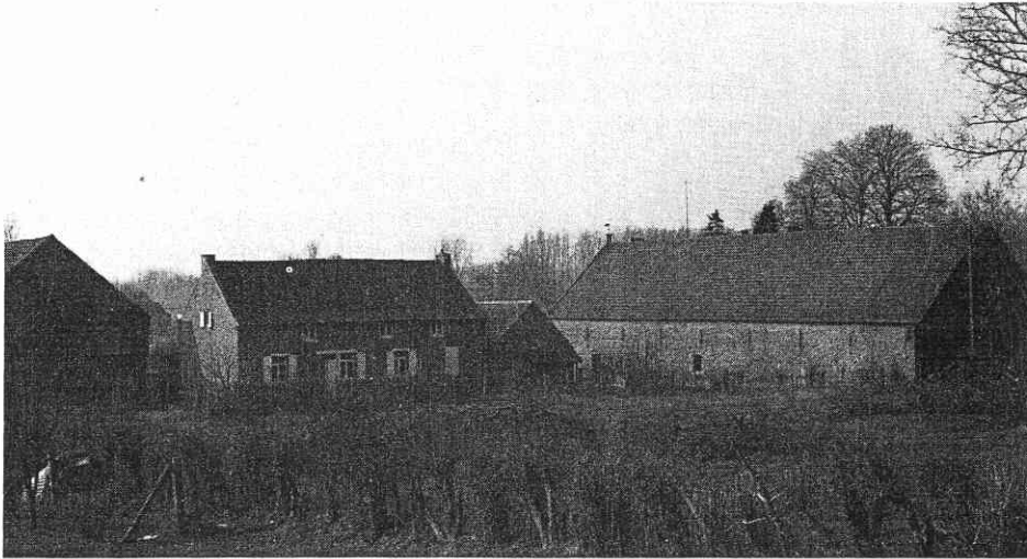
Rechts op de foto de enorme graanshuur, en links een recenter hoevetje, gebouwd op de funderingen van wat - waarschijnlijk - eens de kapittelzaal was.
