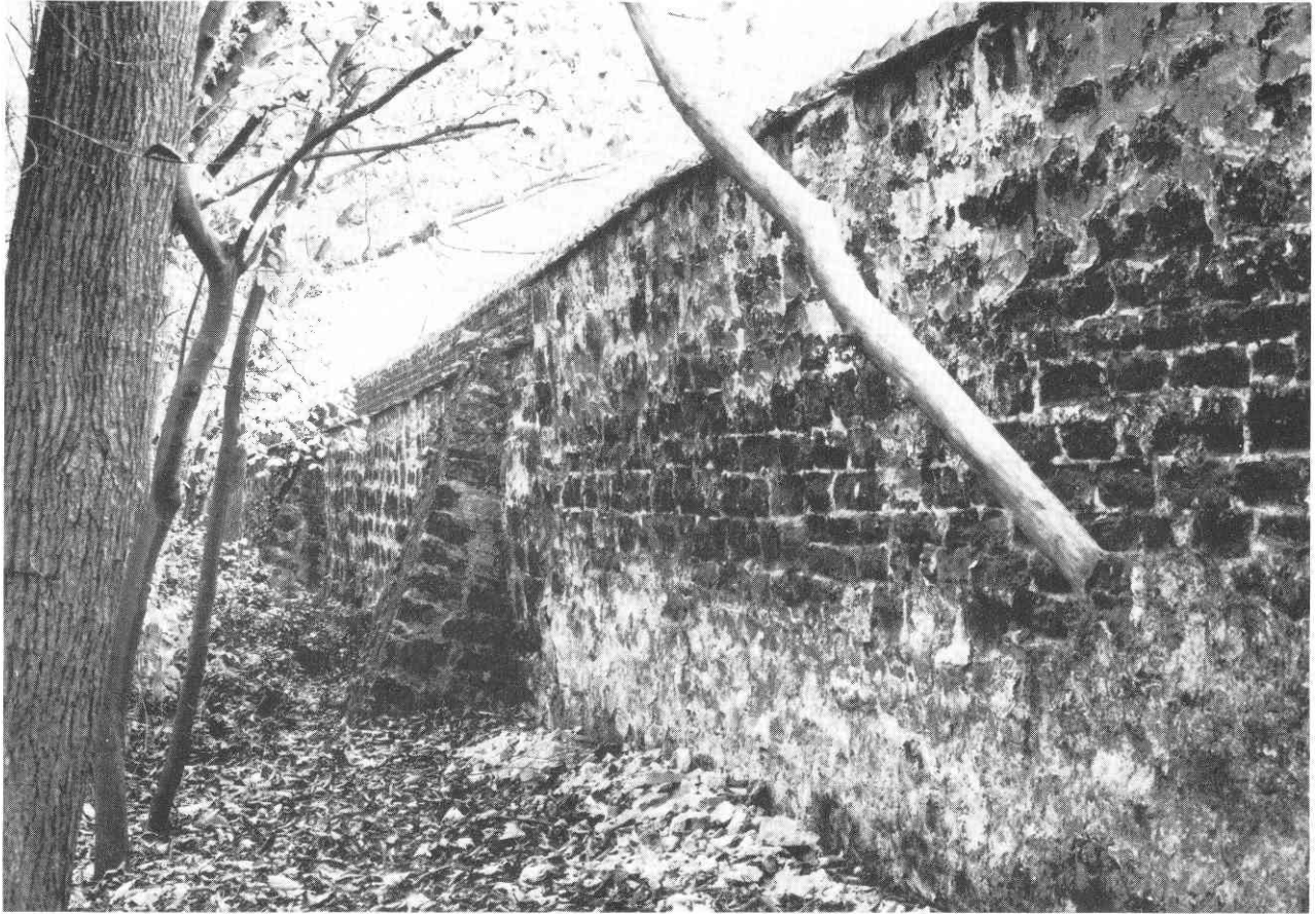
Afb. 4. — De slotmuur, opgetrokken in ijzerzandsteen.
